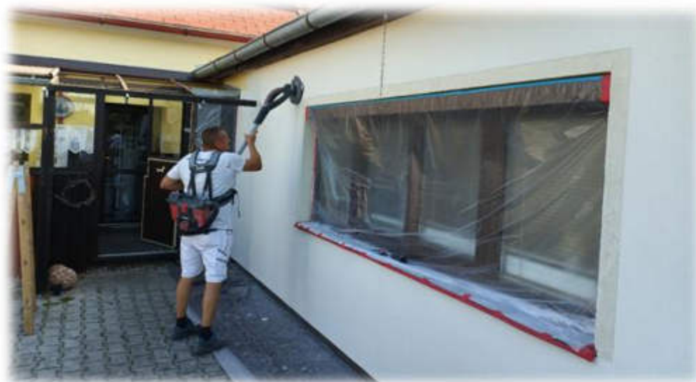
Ukázka broušení fasády aku Giraffe Flex. Možnost zapůjčení.
